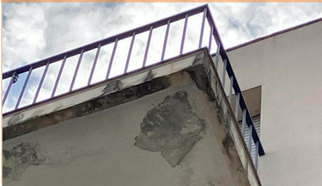
Mauvaise étanchéité des balcons
